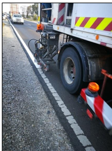
16-18. kép: Gépi útburkolatjel felújító festés
