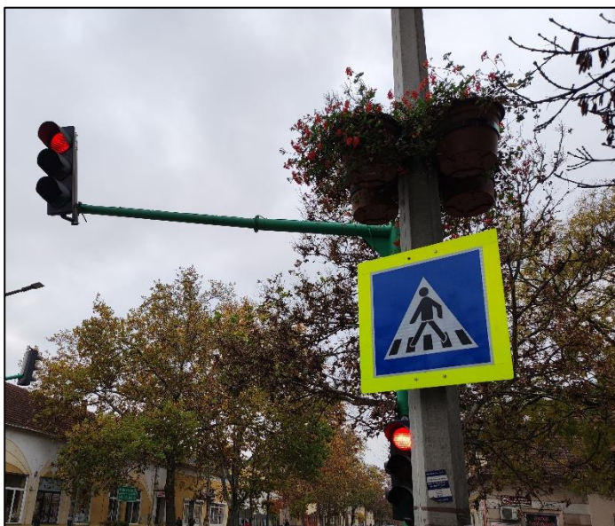
41-42. kép: Útfelújítás keretében magasabb fényvisszavető képességűre cserélt közúti jelzőtábla és forgalomirányító fényjelzőkészülék oszlopfestése
