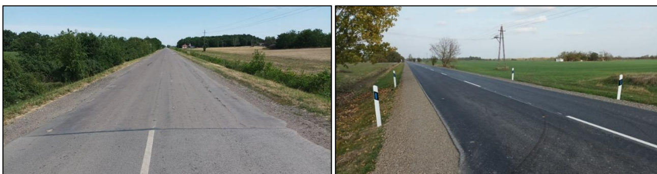
32-33. képek: 4631. j. ök. út 5+550 - 7+304 km szelvények közötti szakaszának felújítása (előtte - utána)
