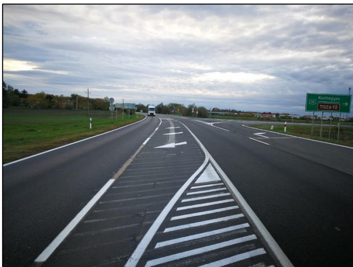
45-46. kép: 4-34. számú főutak csatlakozásában besorolást elősegítő sáv kialakítása
